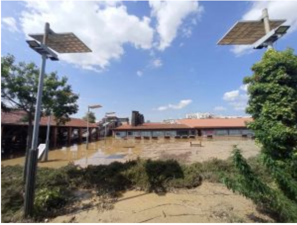
Το κτίριο Τσαλαπατά.
